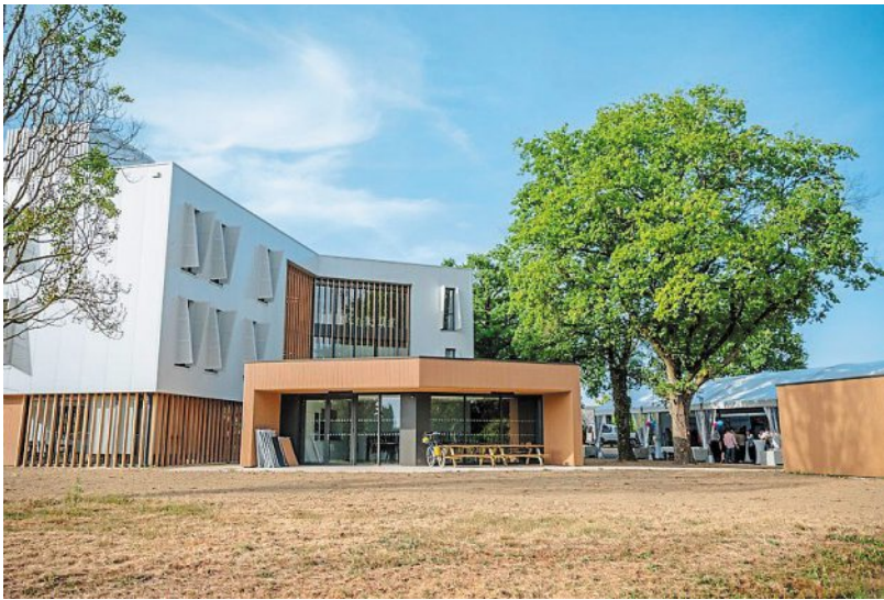
Le bâtiment de 930 m², érigé non loin du centre de tri de la Poste, est doté de panneaux photovoltaïques et de bornes de recharge électriques.
